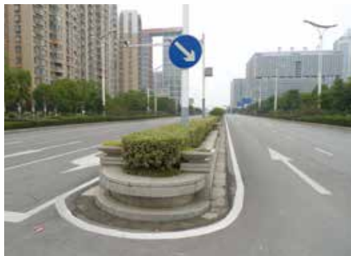
图1-49 南京新区具备一定高度的中央分车带
