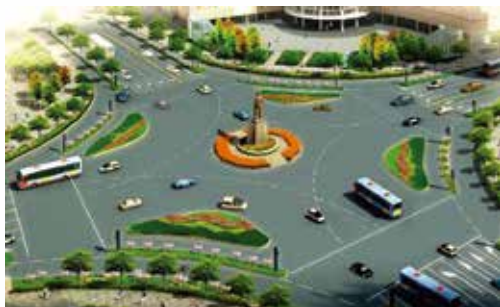
图1-14 南京市中心导流岛及中心岛 ①
