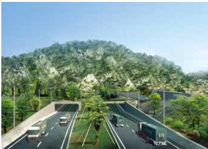
图1-65 某隧道入口的遮光种植
