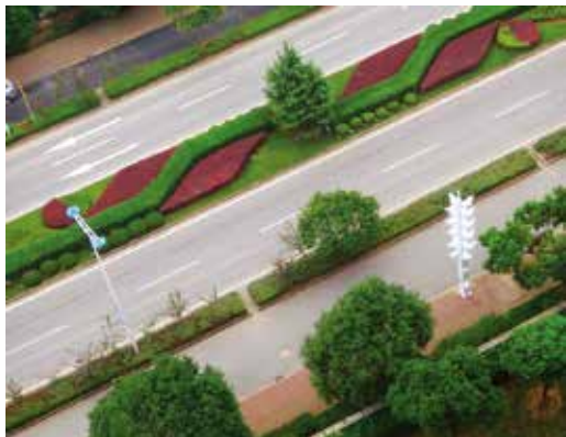
图1-25 四板五带式城市道路
